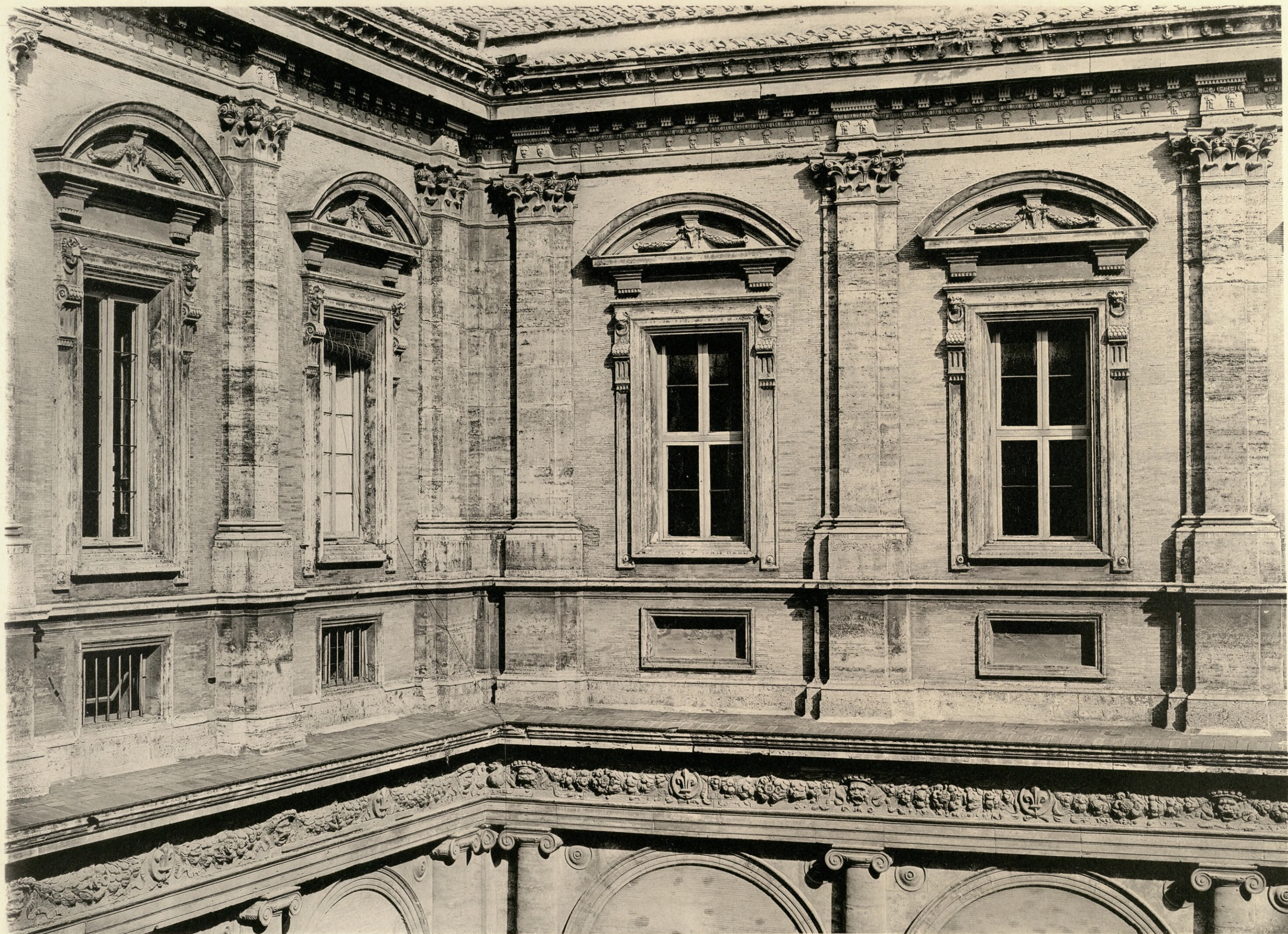
PALAZZO FARNESE — CORTILE - PARTICOLARE DELL'ULTIMO PIANO GIACOMO DELLA PORTA
