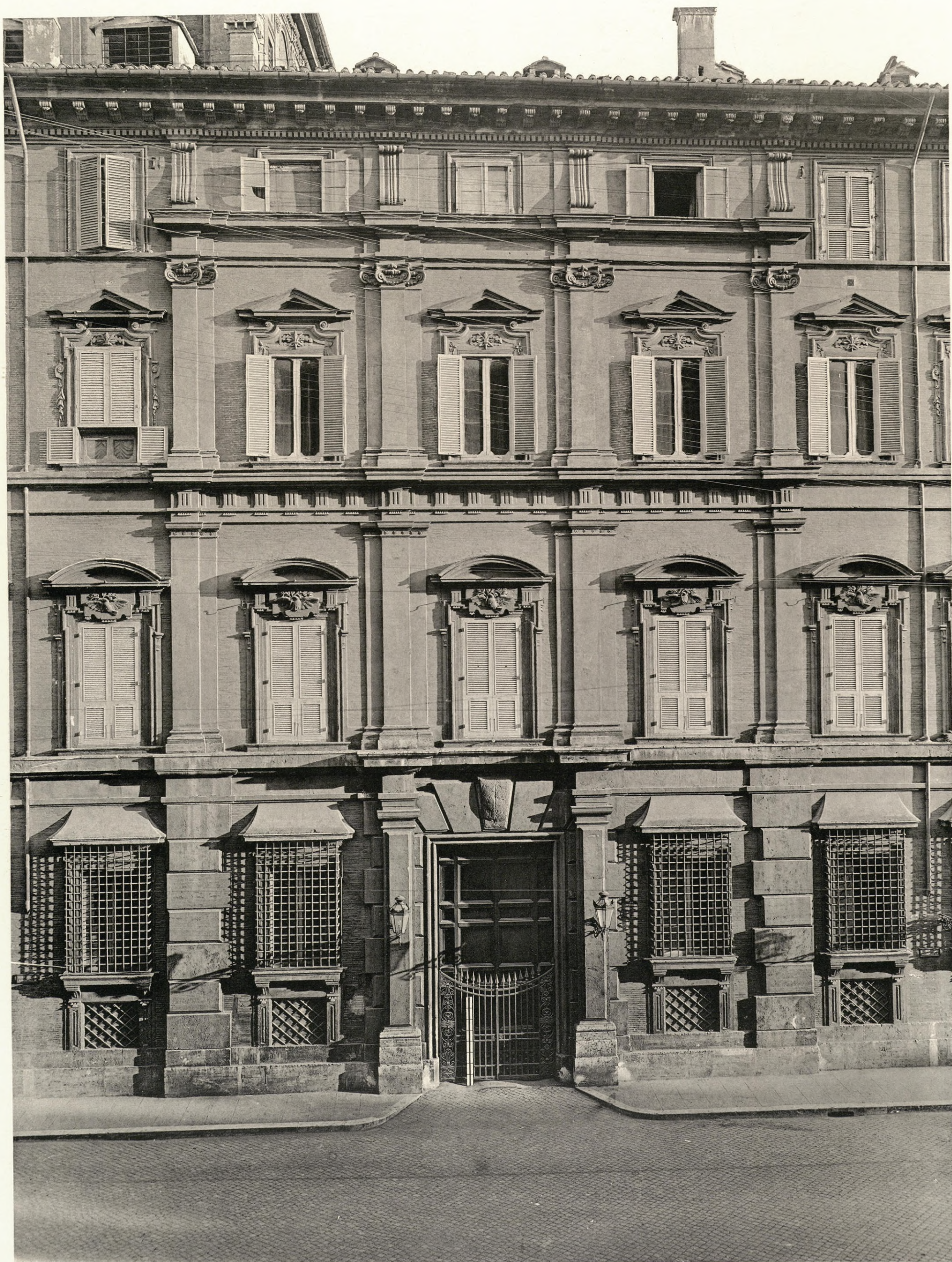
PALAZZO DORIA — PROSPETTO SULLA PIAZZA DEL COLLEGIO ROMANO
