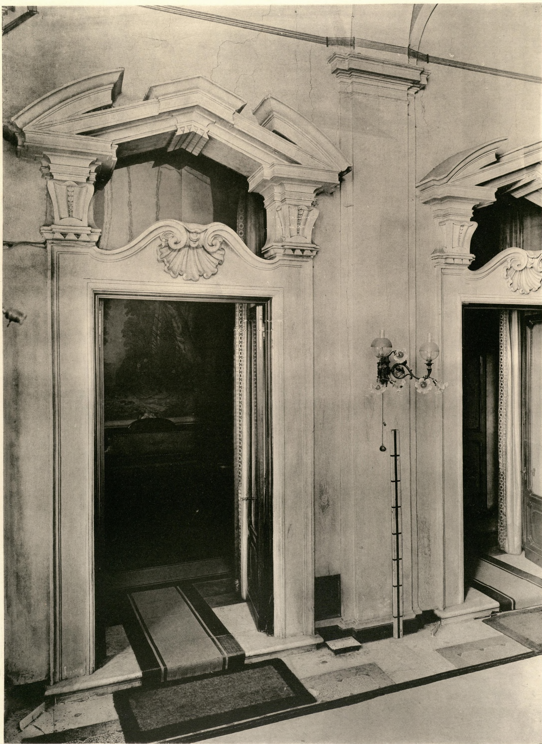
PALAZZO DELLA CONSULTA — PORTA INTERNA
