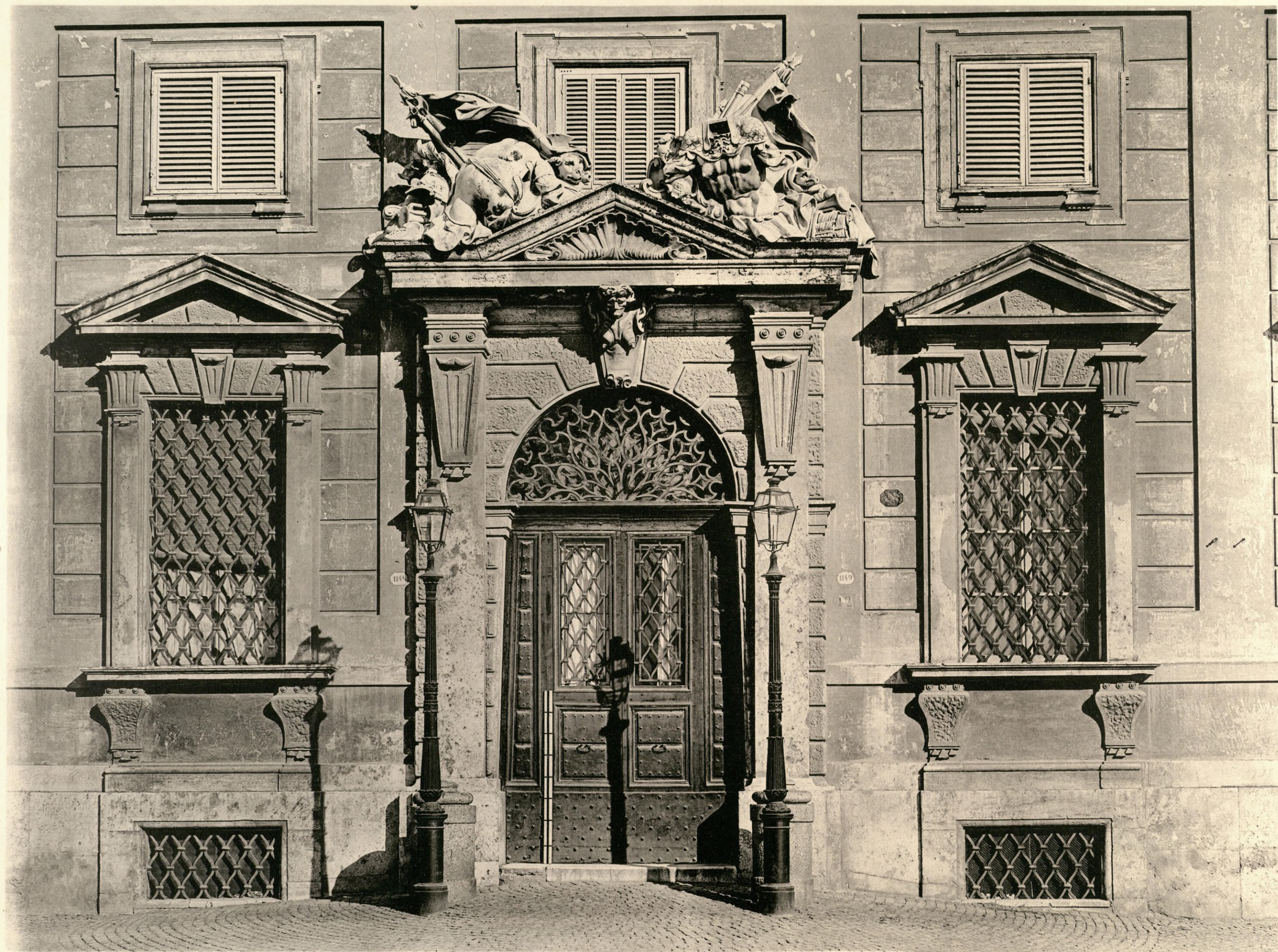
PALAZZO DELLA CONSULTA — PORTONE LATERALE FERDINANDO FUGA
