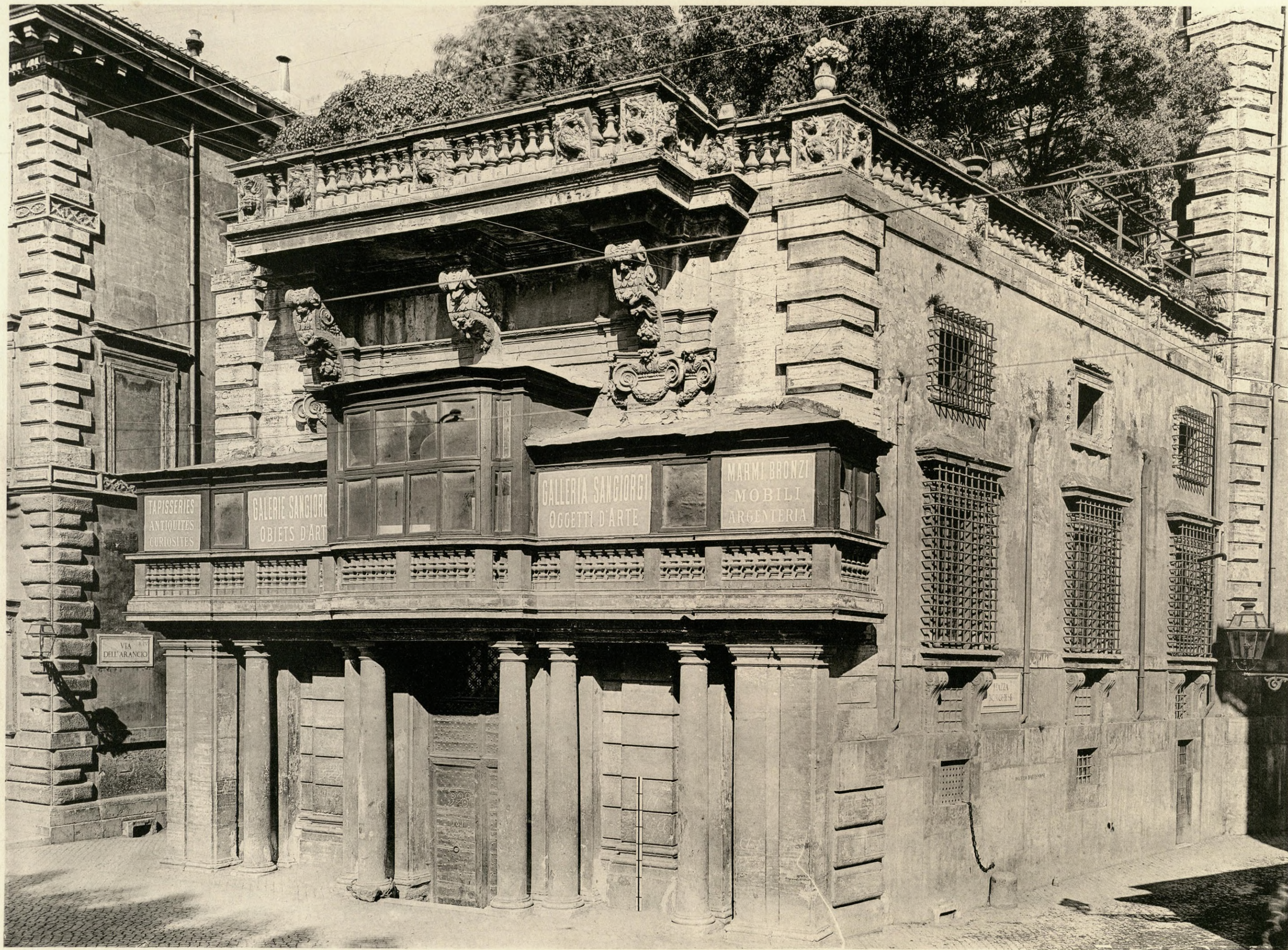
PALAZZO BORGHESE — LOGGIA VERSO LA VIA DI RIPETTA
