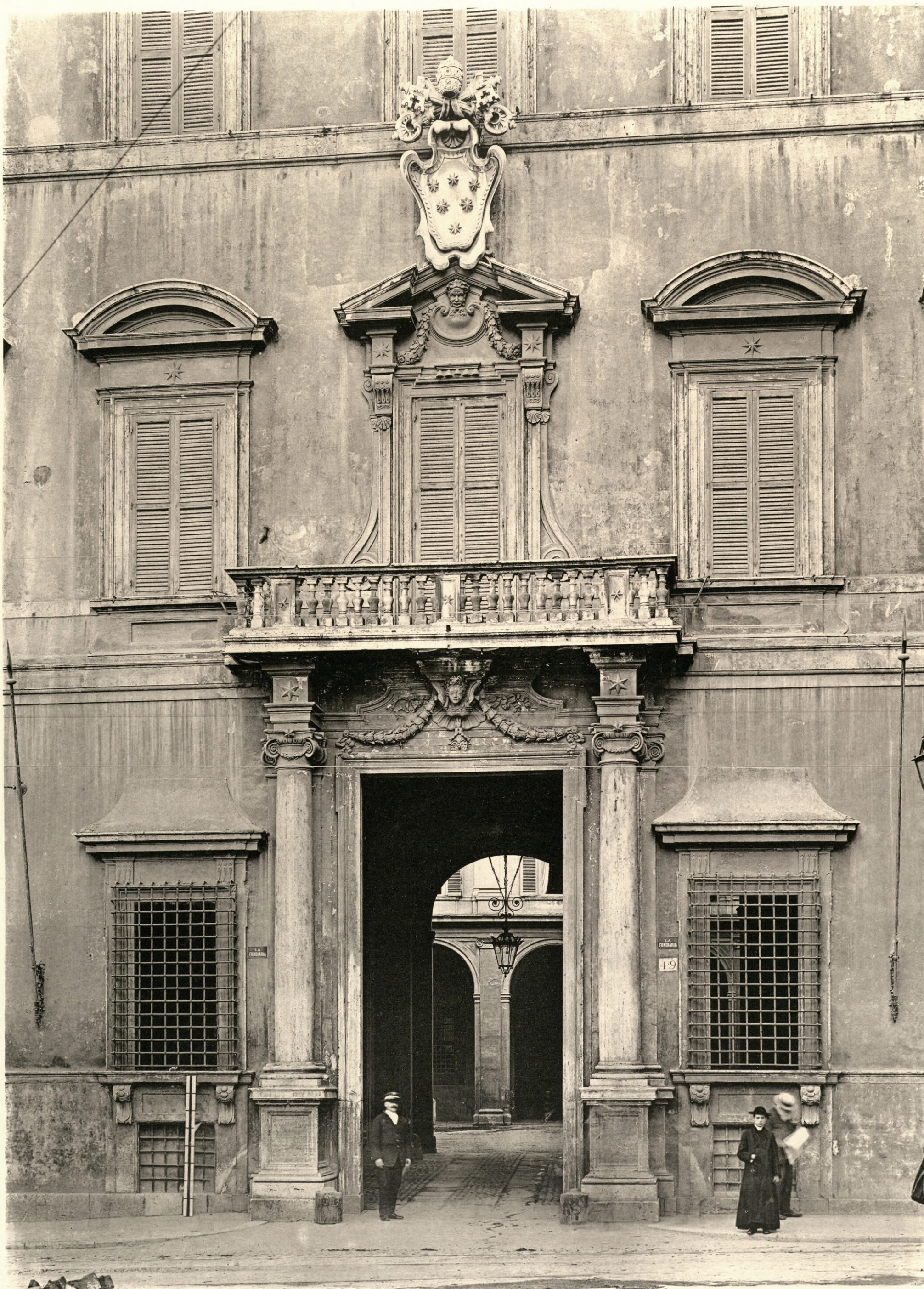
PALAZZO ALTIERI — PARTICOLARE DEL PROSPETTO
