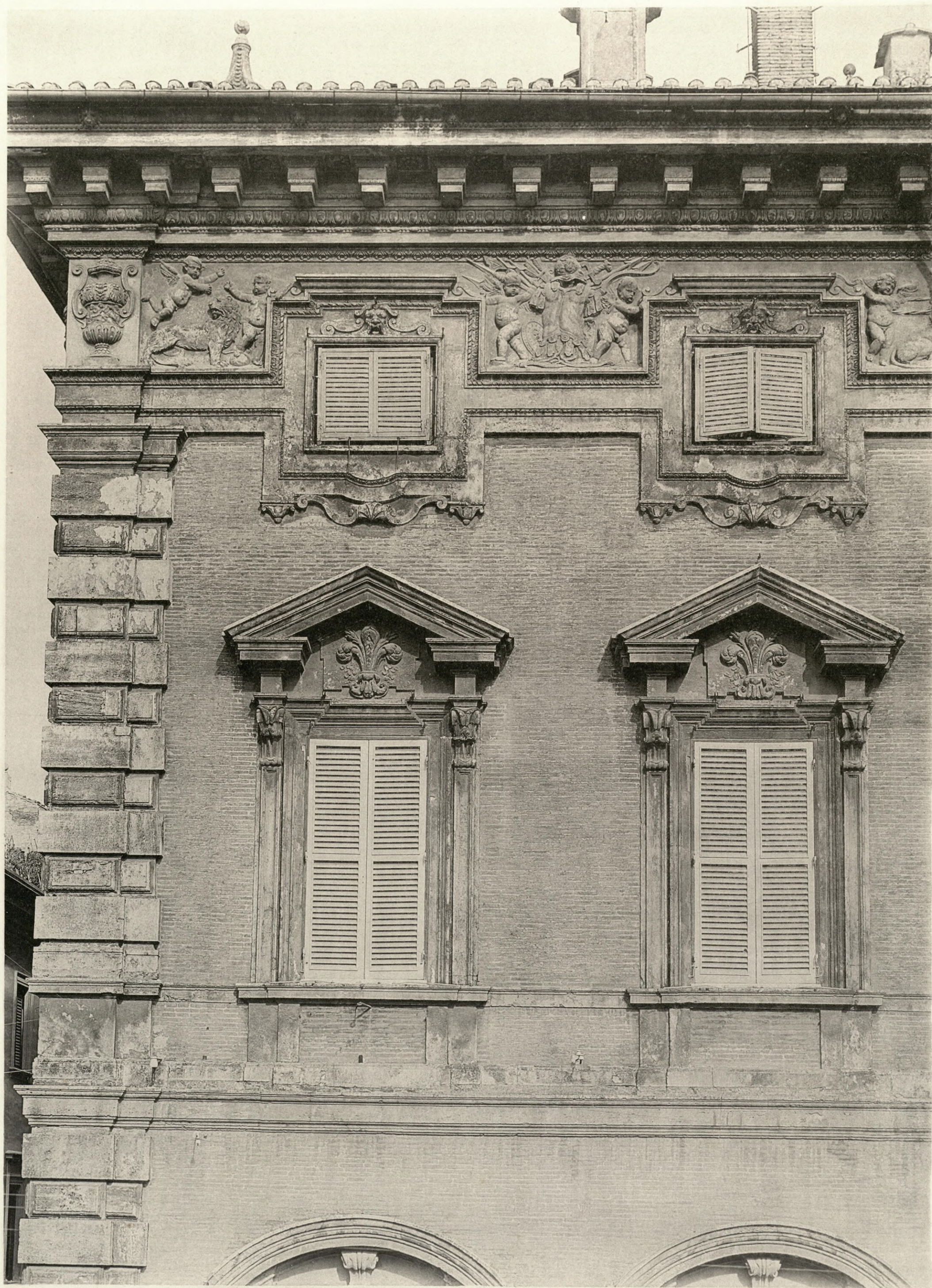
PALAZZO MADAMA — FINESTRE DEL 2° PIANO E CORNICIONE
