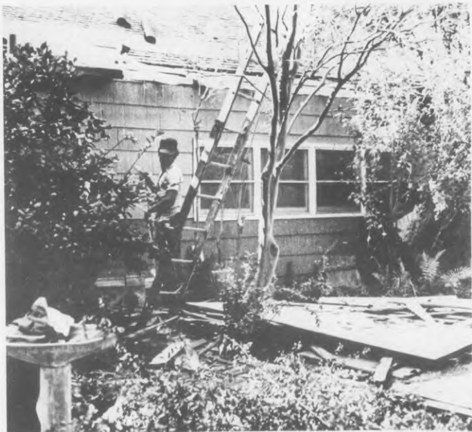
TECHO—Se han estado haciendo reparaciones en las residencias de la ciudad de Houston a través del programa de rehabilitación residencial de Community Development.
