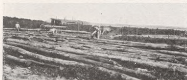
Slicing hardwood piles for T. T. Co. Matanzas Wharf
