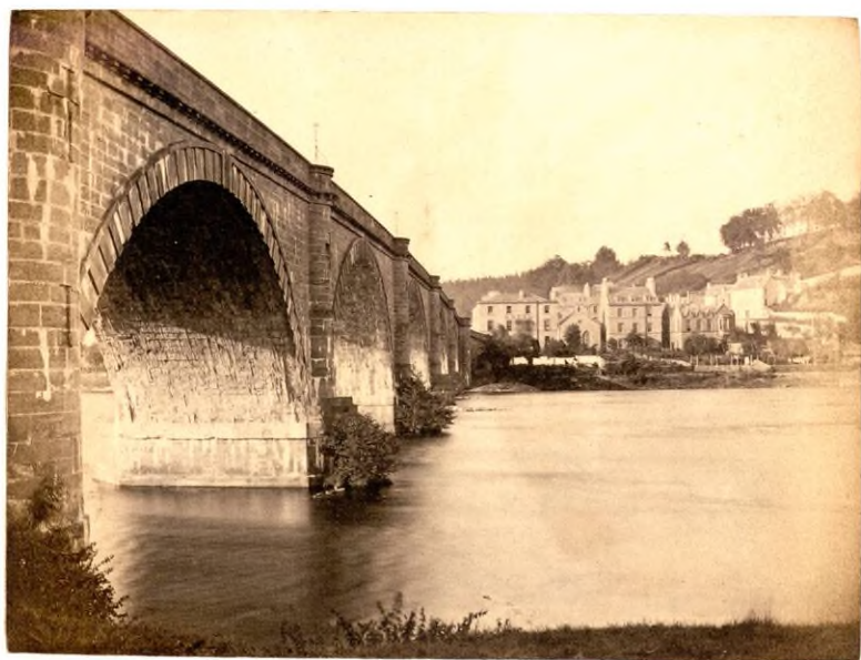
The Bridge. Dunkeld.
