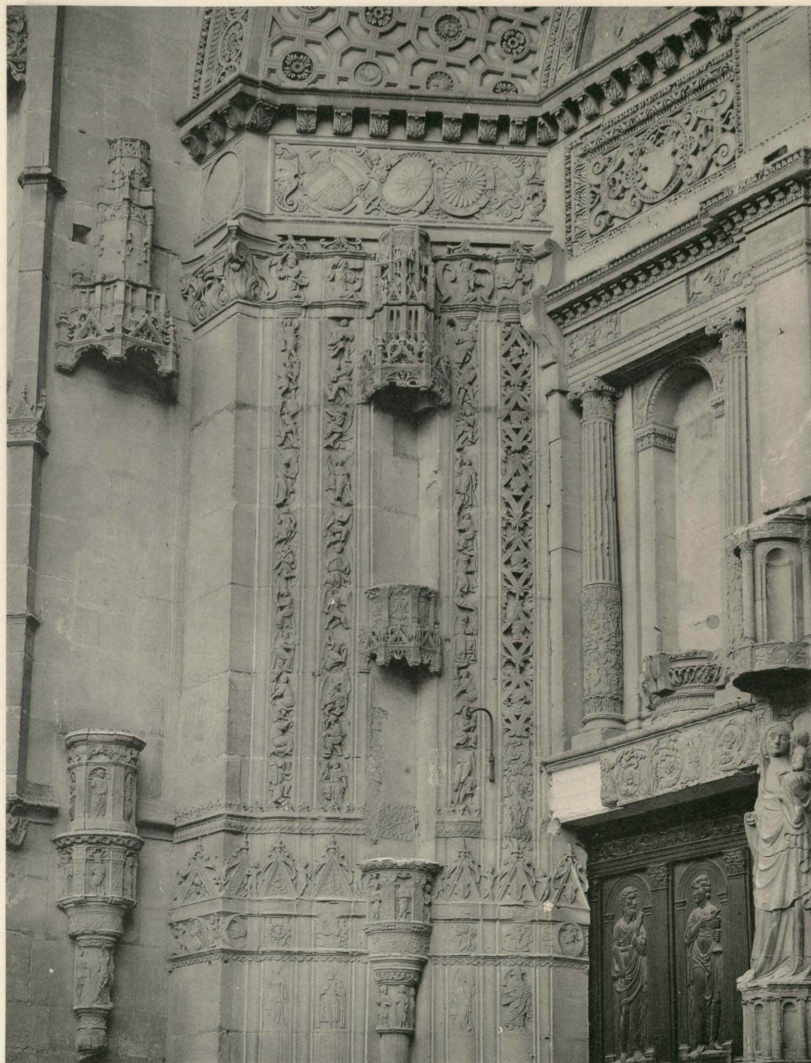
GISORS (Eure). ÉGLISE SAINT-GERVAIS. Montants du portail central de la façade occidentale. Second quart du XVI e siècle.
