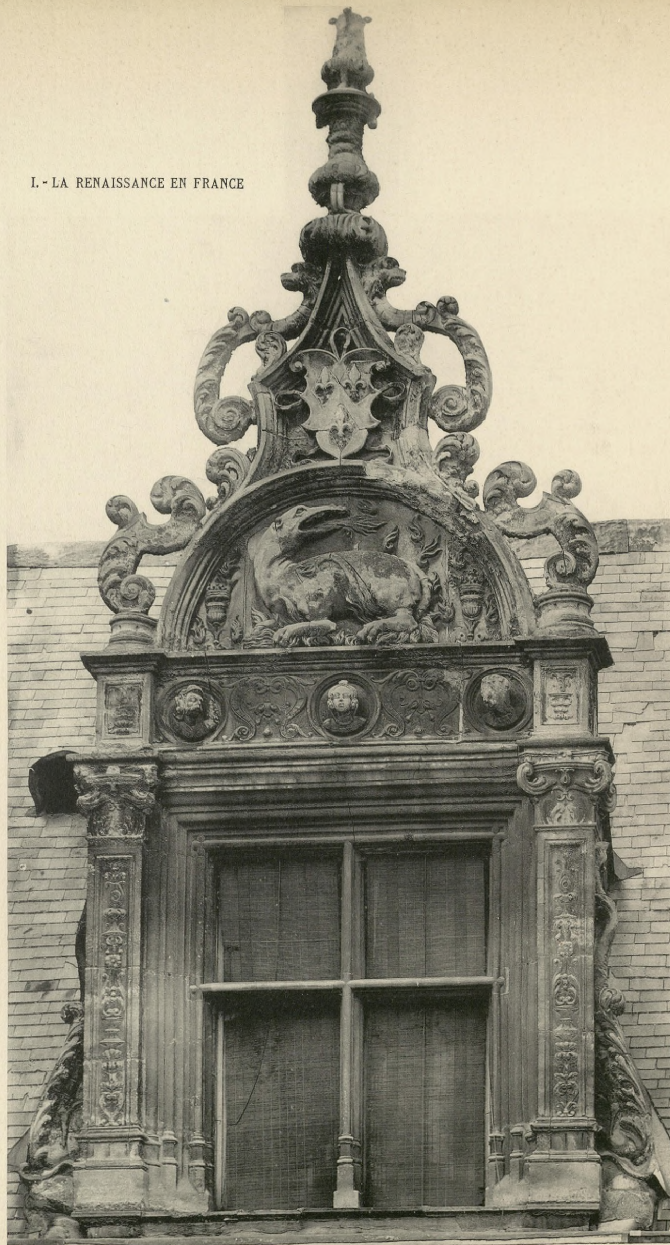
CAEN. HOTEL DE THAN. Lucarnes de la façade sur cour. Première moitié du XVI e siècle.
