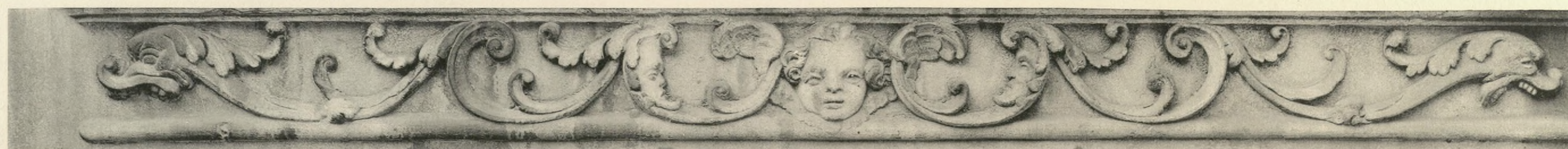
CAEN. HOTEL DE THAN. Cartouches et tablettes de fenêtres de la façade sur cour. Première moitié du XVI e siècle.
