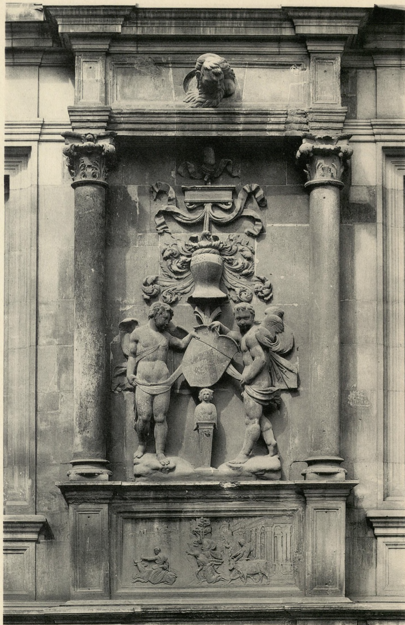
CAEN. HOTEL LE VALOIS D'ESCOVILLE, façade à l'ouest de la cour, trumeaux du premier étage. 1534-1541.
