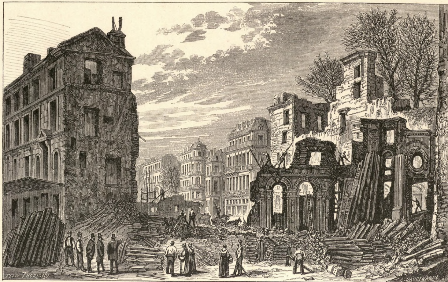
Percement du boulevard Saint-Germain, vue prise de la rue Saint-Dominique (1877).
