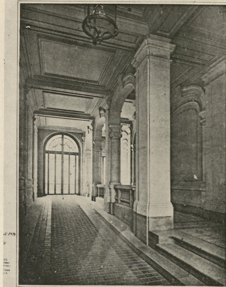
PASSAGE DE LA PORTE COCHERE ET PASSAGE DES FIÉTS
