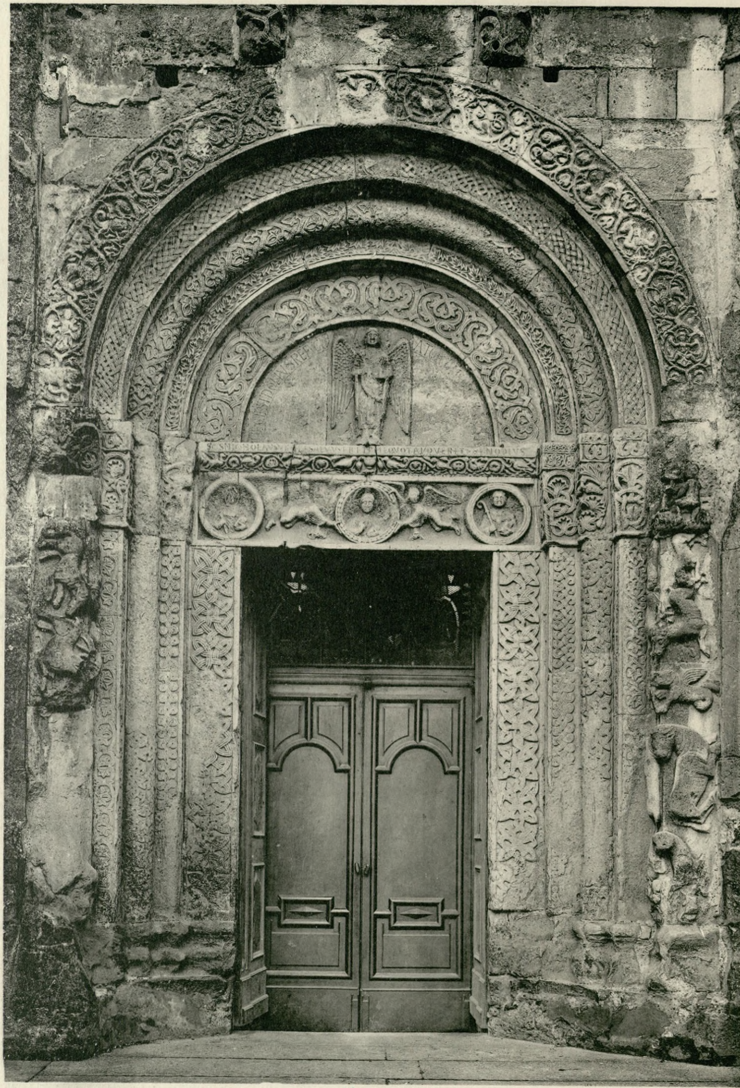
1. PORTAIL DE LA FACE NORD. 2-5. FRISES DE LA FAÇADE OCCIDENTALE. PREMIÈRE MOITIÉ DU XII e SIÈCLE.
