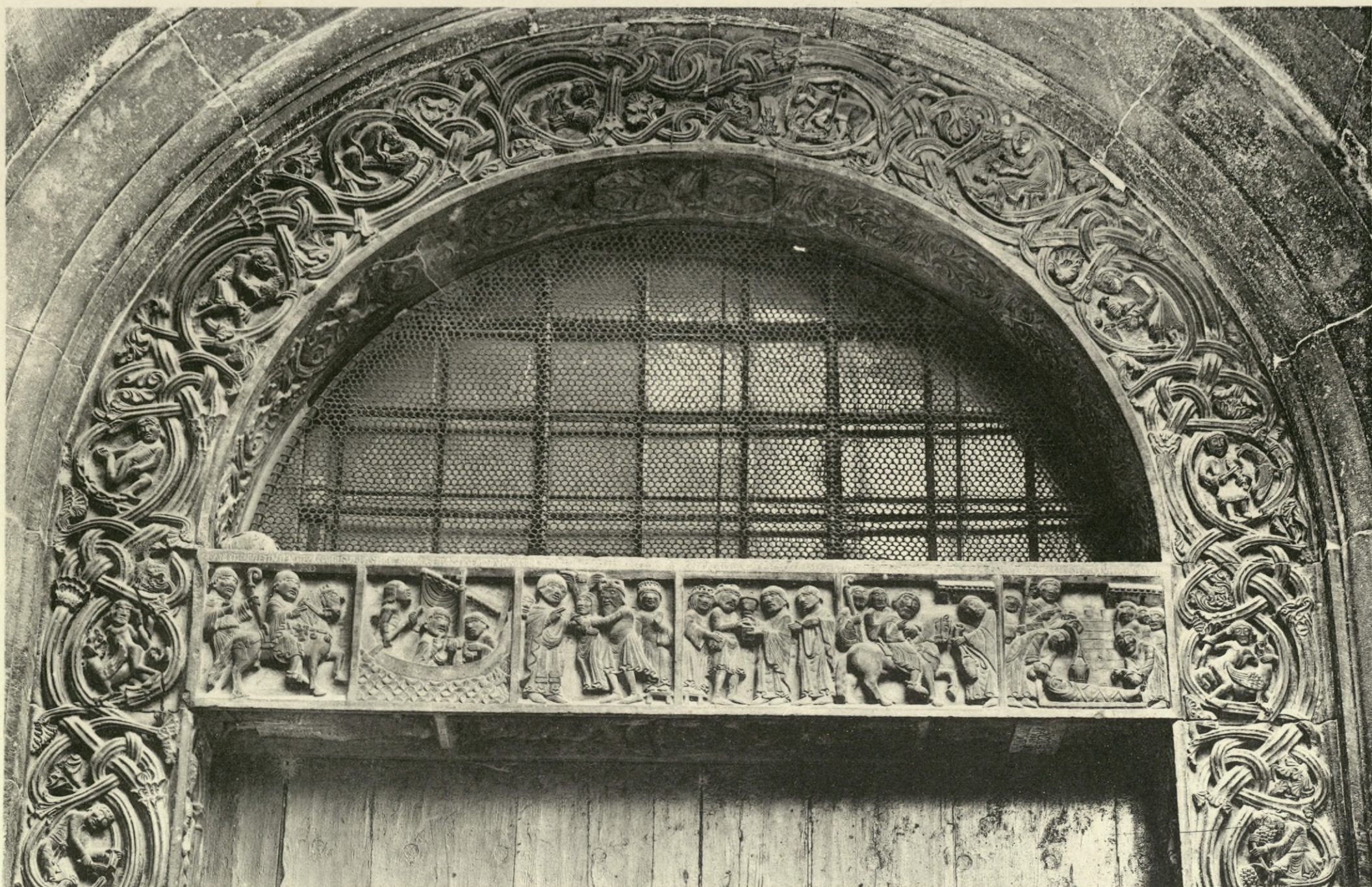
1. ARCHIVOLTE ET LINTEAU DU PORTAIL NORD; 2. ARCHIVOLTE ET LINTEAU DU PETIT PORTAIL SUD.
