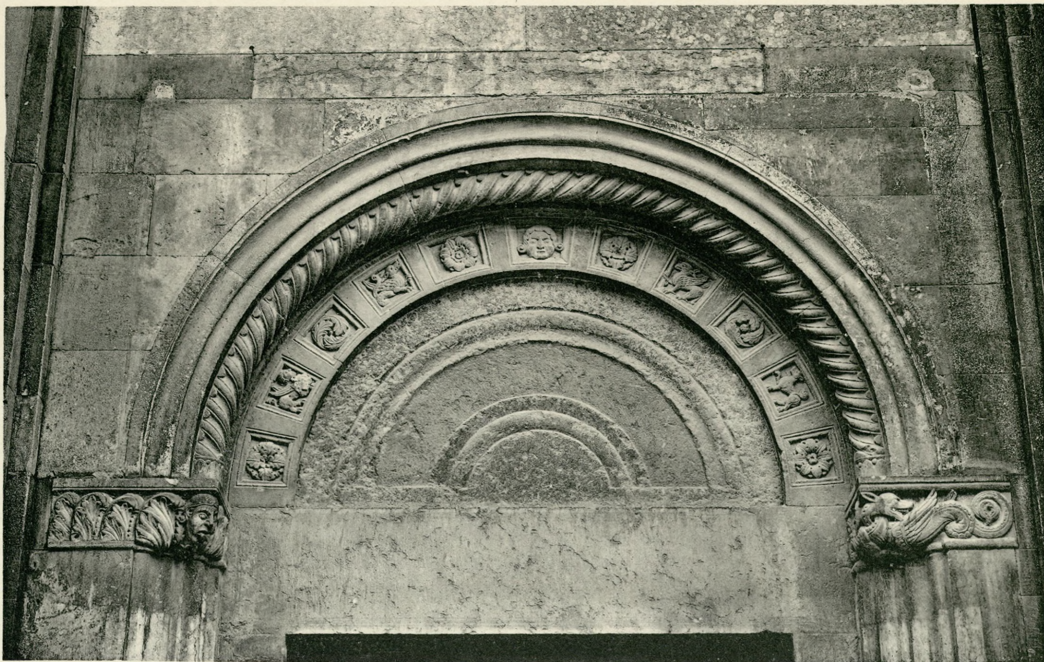
DÉTAILS DE LA FAÇADE OCCIDENTALE; ARCHIVOLTES ET TYMPANS DES PORTES LATÉRALES. PREMIÈRE MOITIÉ DU XII e SIÈCLE.
