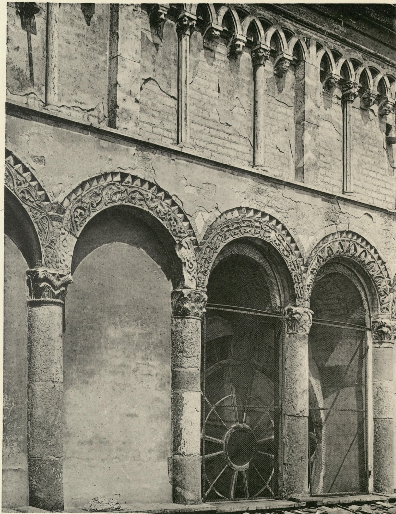
1. ARCADES SUPÉRIEURES DE LA FACE SUD DU CHŒUR; 2. SOMMET DU FRONTON DE LA FAÇADE OCCIDENTALE; 3. COURONNEMENT DE L'ABSIDIOLE DU CROISILLON SUD DU TRANSEPT.
