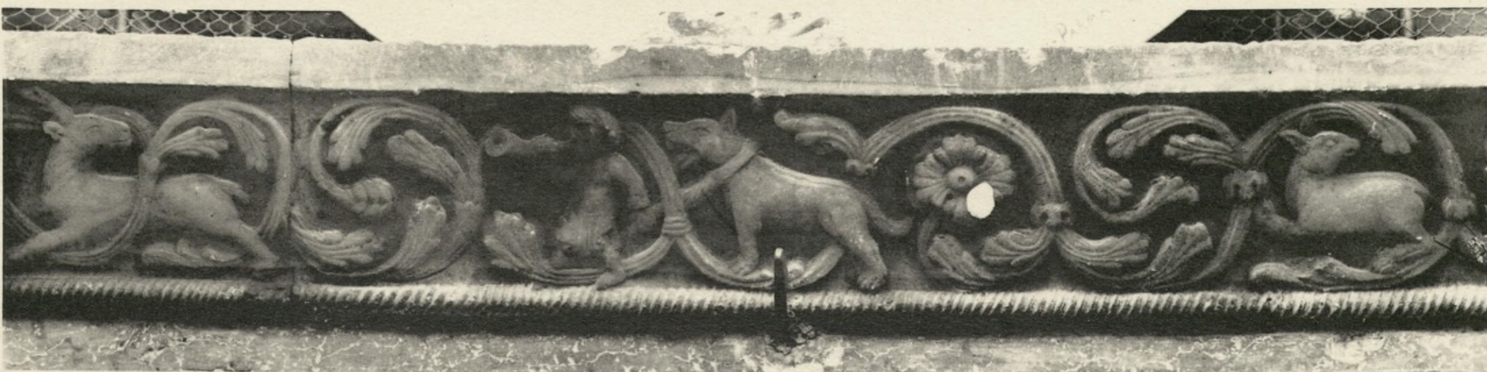
1, 2 ET 3. ARCHIVOLTE DU PORCHE DE LA FAÇADE OCCIDENTALE. 4 ET 5. FRISE ET LINTEAU DE LA PORTE D'ENTRÉE PRINCIPALE.
