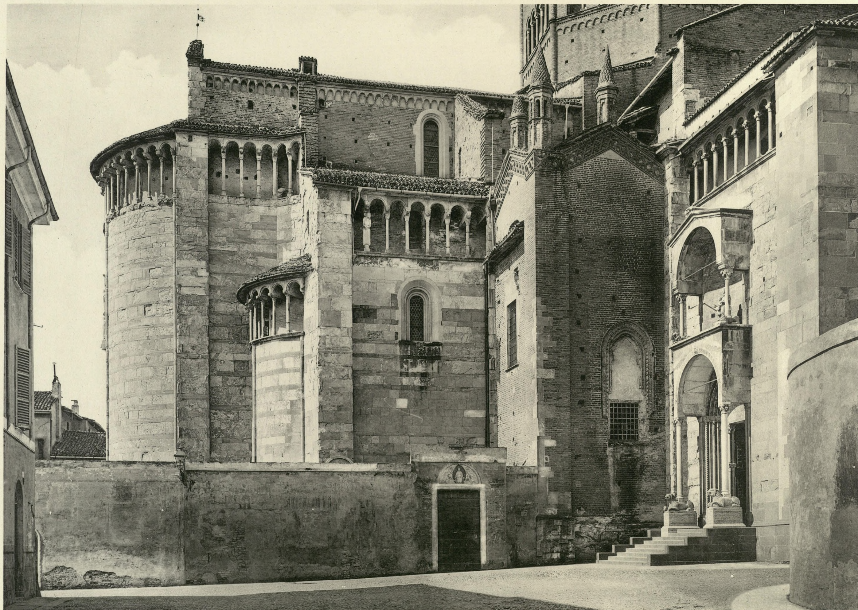
FAÇADE SEPTENTRIONALE DU CHŒUR.
